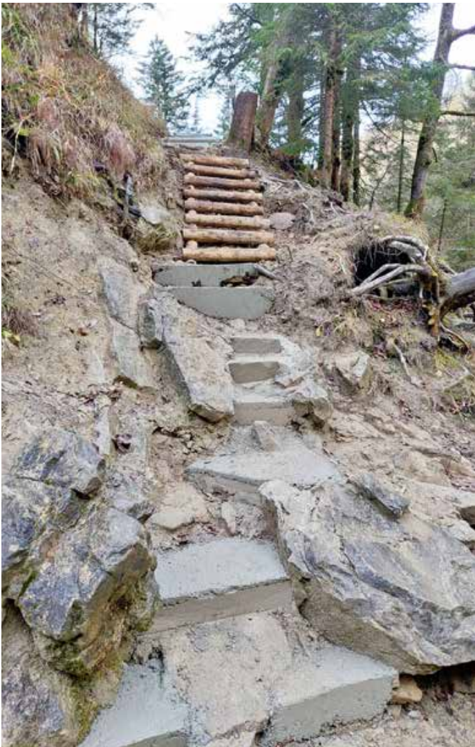
Die naturverträgliche Wegsanierung musste im November aufgrund des Wintereinbruchs abgebrochen werden und wird nun fortgesetzt. Foto: Naturpark Nagelfluhkette
